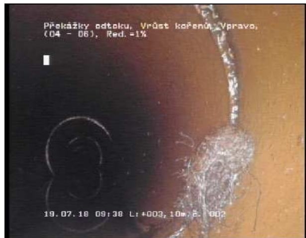
Foto 002 Videopáska: 1/1 Stav HP-R 3,10 m 4 - 6 Uhr Překážky odtoku, Vrůst kořenů, Vpravo, Redukce průřezu = 1%
