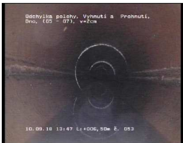
Foto 053 Videopáska 2: 1/8 Stav LB-U 6,50 m 5 - 7 Uhr Odchylka polohy, Vyhnutí a Prohnutí, Dno, Vyhnutí = 2cm; V délce od 6,50 do 9,90m
