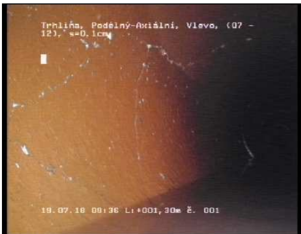
Foto 001 Videopáska: 1/1 Stav RX-L 1,30 m 7 - 12 Uhr Trhlina, Paprskovité trhliny, Vlevo
