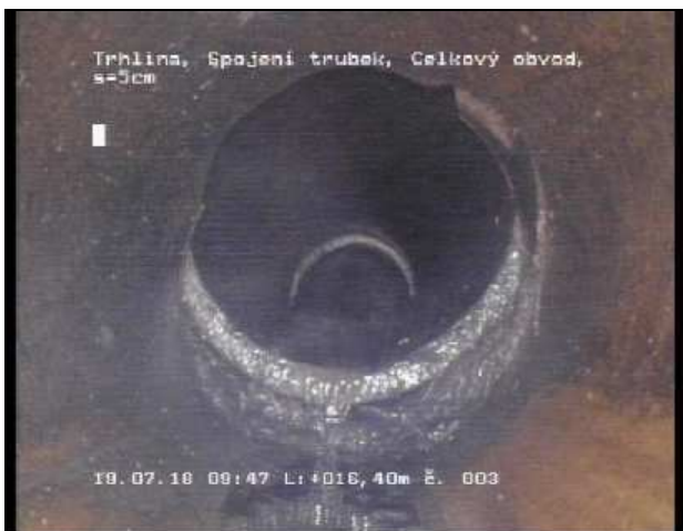
Foto 003 Videopáska: 1/1 Stav LH-- 16,40 m Odchylna polohy, Horizontální, Celkový obvod, Přesazení = 4cm
