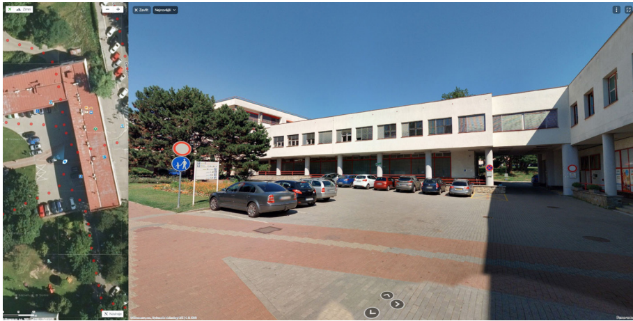
04 Pohled z areálu na objekt E
