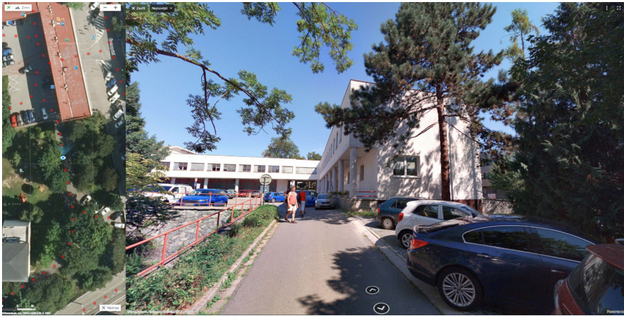
03 Pohled na vstupní křídlo (objekt A a E)
