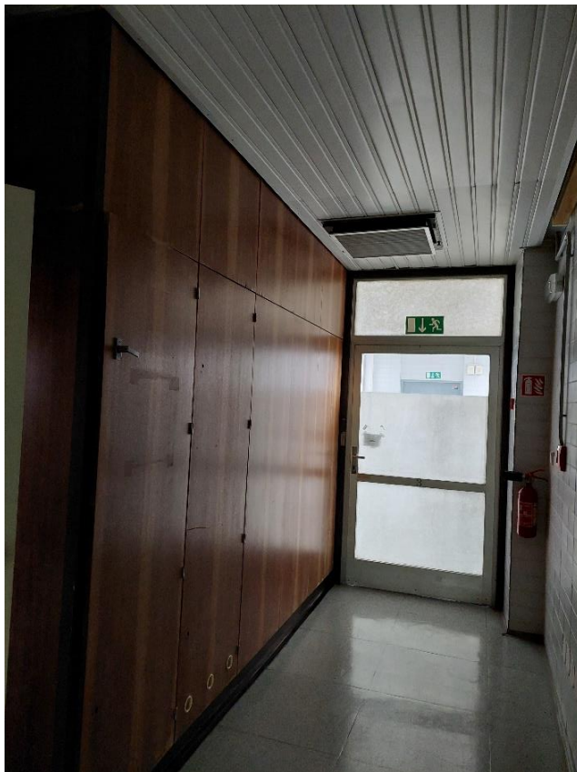
Obr.č.5 – Obložení šachty s revizními dvířky m.č. 4044
