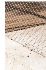
Oplocení - kombinace betonové podezdívky a lankového plotu nataženého mezi ocelové sloupky
