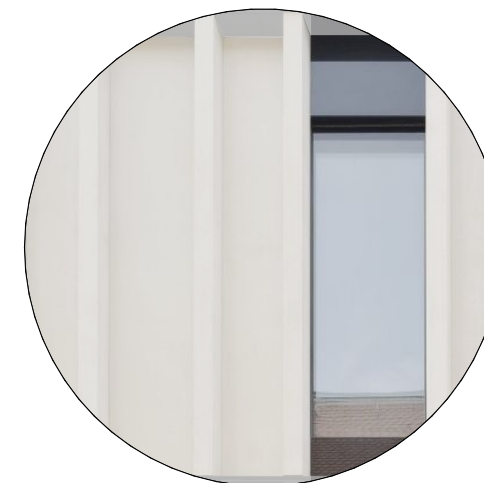
Sloupky na fasádě a skleněný obklad
