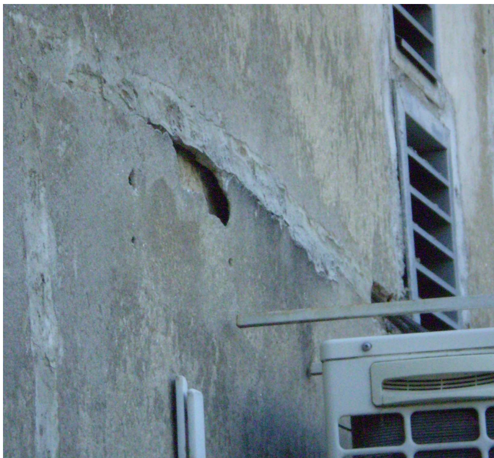
Obr. 28. Budova F z východní strany, odchlupující se omítka.
