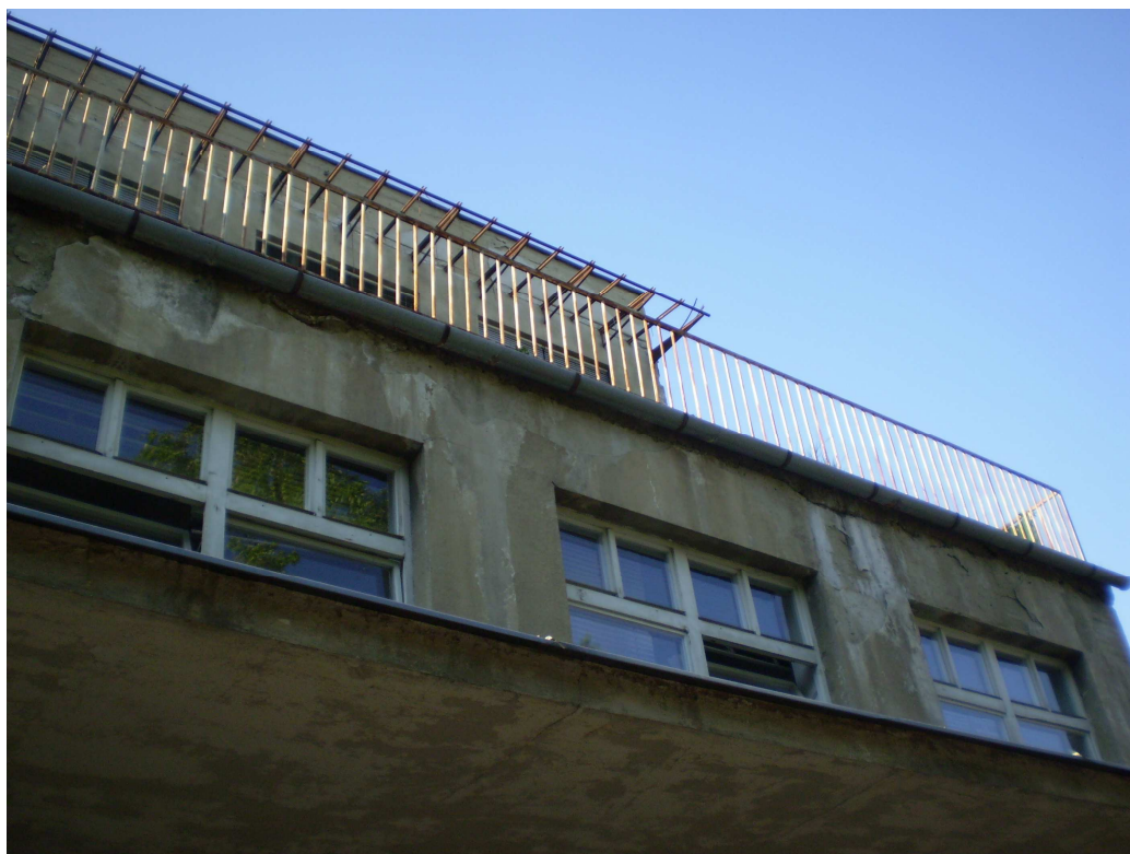
Obr. 26. Budova F, praskliny ve zdi, šterbiny pod oplechováním balkónu.
