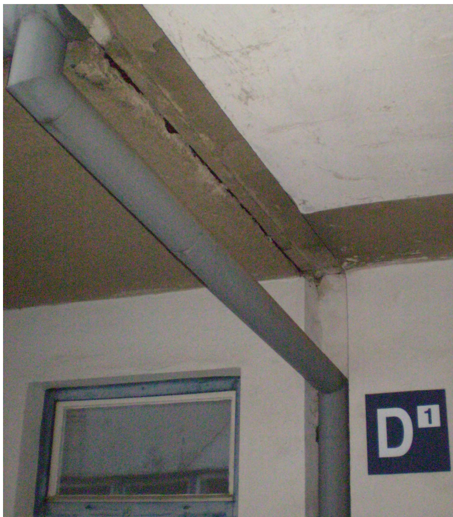
Obr. 46. Budova D1, štěrbiny ve stropě.
