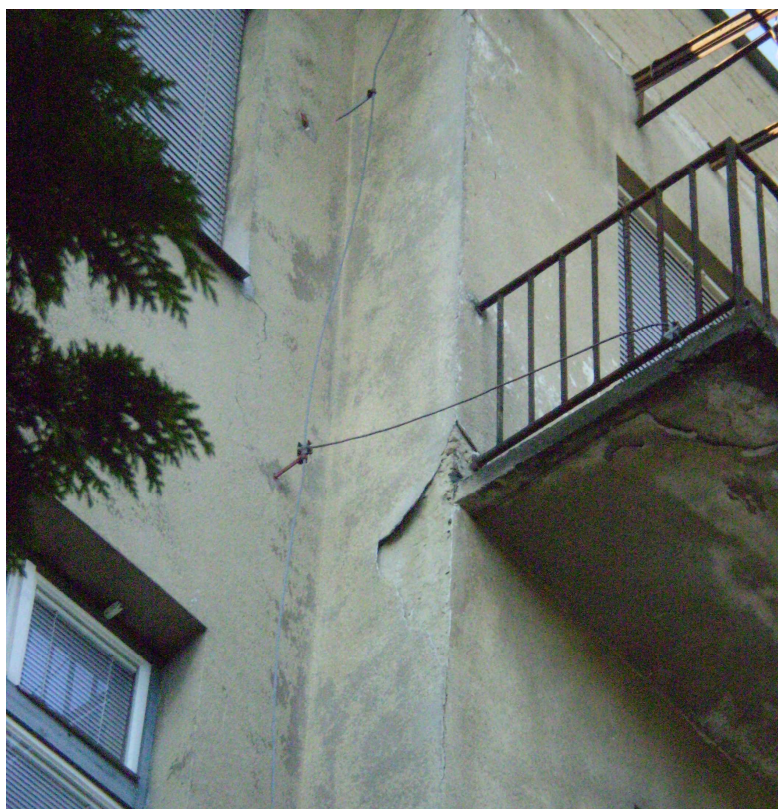
Obr. 25. Budova F, odchlípující se omítka.
