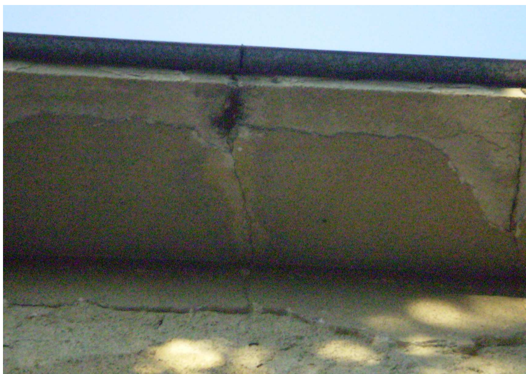
Obr. 51. Budova C ze západní strany, prasklina pod střechou.
