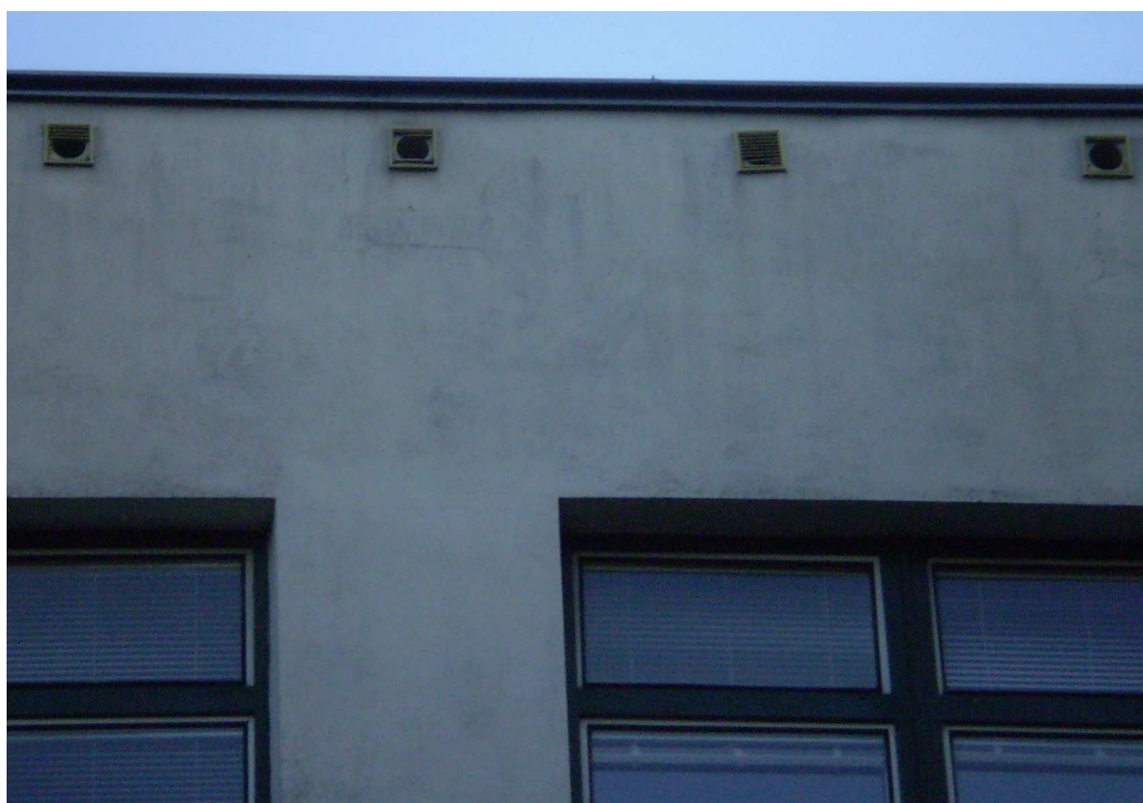
Obr. 14. Budova B, pohled ze severní strany, detail větracích otvorů – u některých chybí mřížky.
