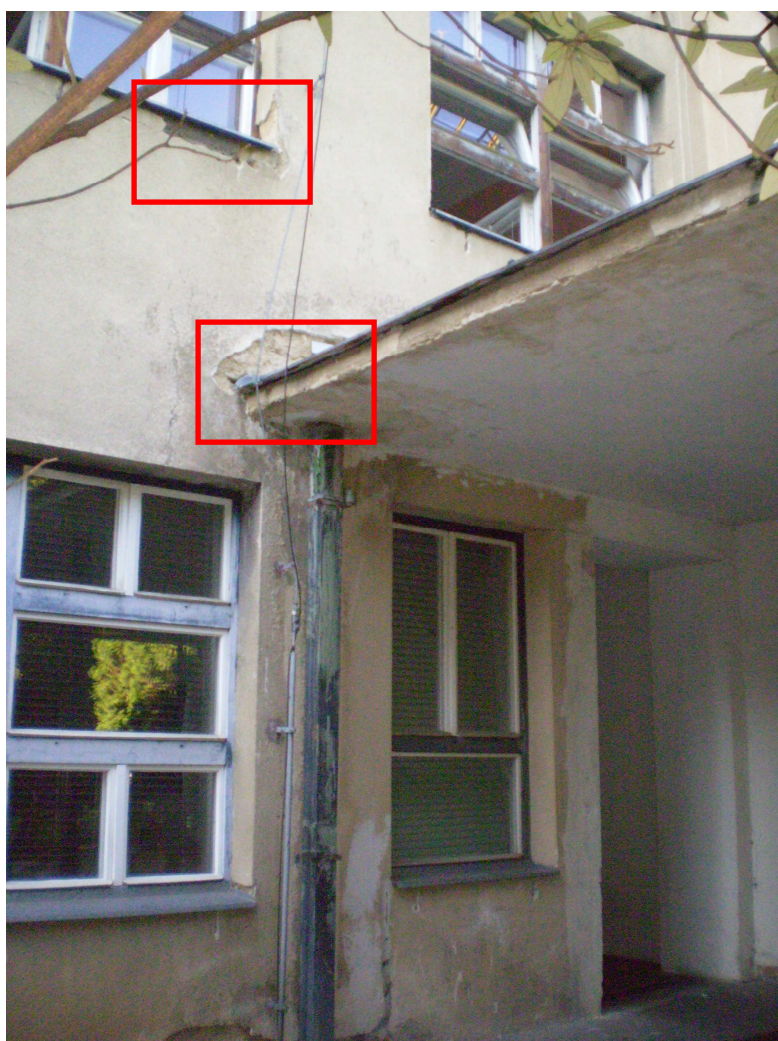
Obr. 42. Praskliny v omítce a pod parapety oken.
