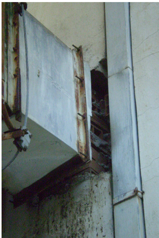
Obr. 37. Otvory okolo komína a okapového svodu.
