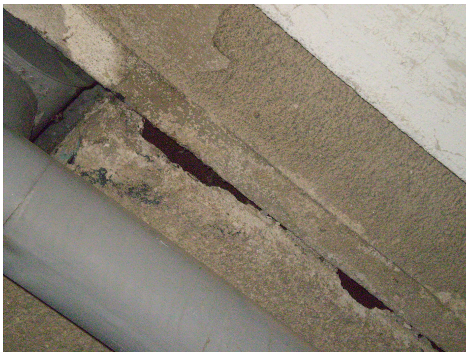
Obr. 47. Budova D1, štěrbiny ve stropě, detail.
