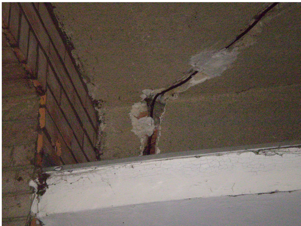
Obr. 6. Průchod mezi budovami A a C, otvory kolem kabelů.
