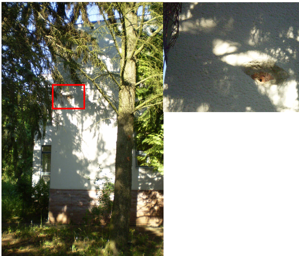
Obr. 3. Budova A, pohled ze západní strany, umístění a detail otvoru v obvodovém plášti.
