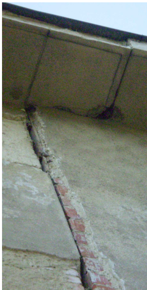
Obr. 22. Budova D1, prasklina ve zdi a škvíry pod oplechováním střechy.
