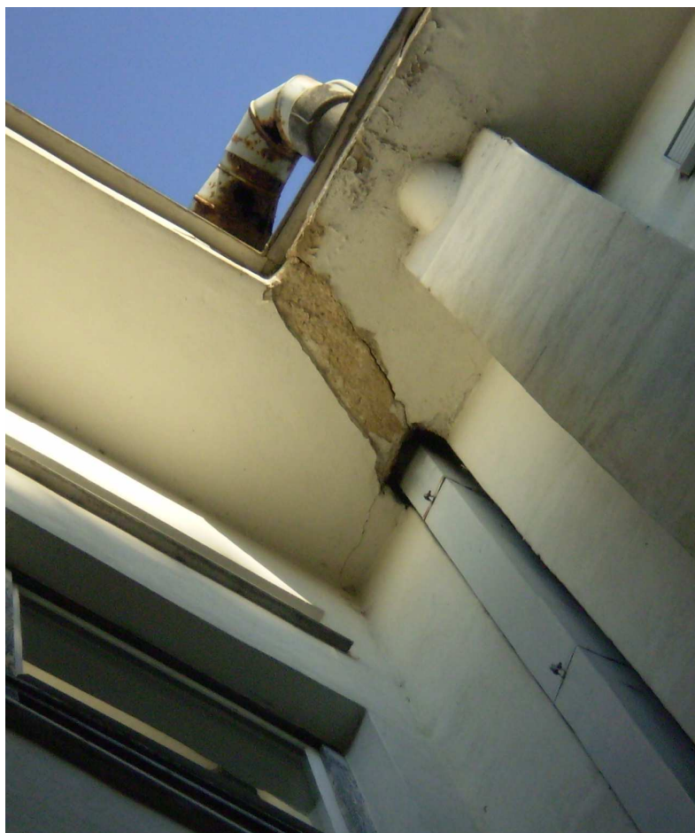
Obr. 32. Budova F ze severní strany, štěrbiny kolem okapového svodu.
