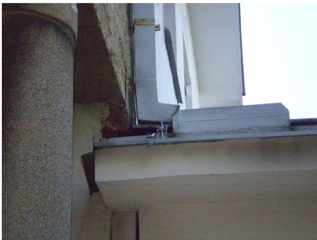
Obr. 19. Průchod mezi budovami C a D, pohled z východní strany, škvíry v oplechování střechy.
