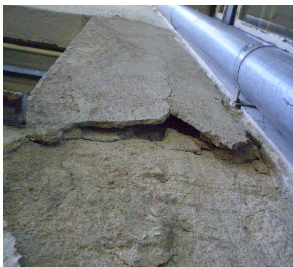
Obr. 4. Budova A, pohled ze severní strany, otvor okolo okapového svodu a praskliny v obvodovém plášti.
