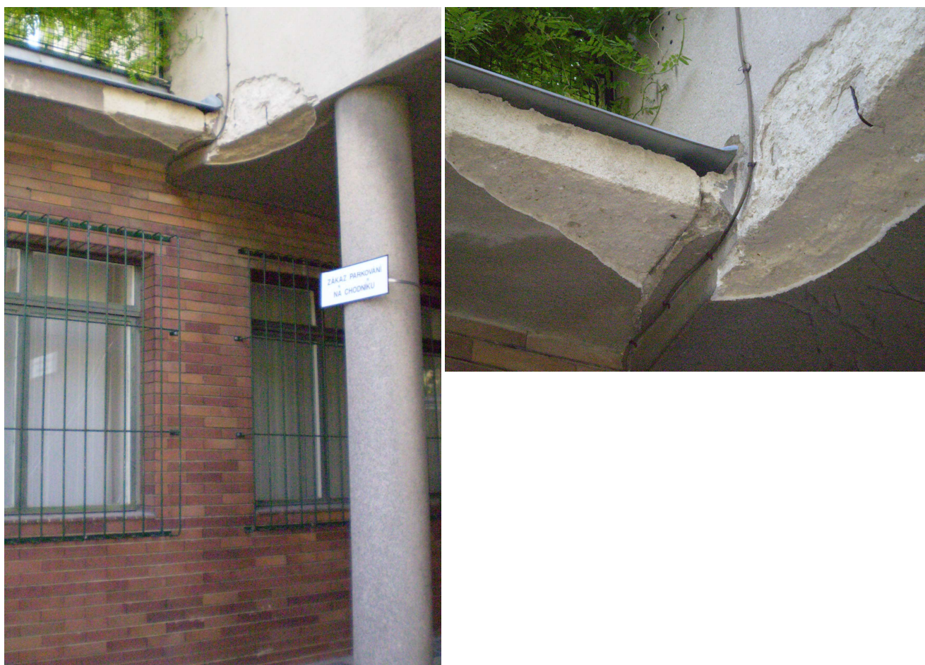
Obr. 10. Průchod mezi budovami C a B, pohled z jižní strany, škvíry pod oplechováním.
