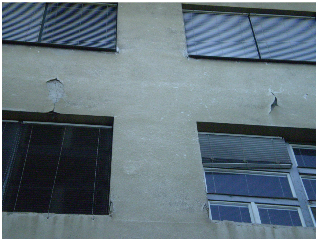
Obr. 24. Budova F, odchlípující se omítka.
