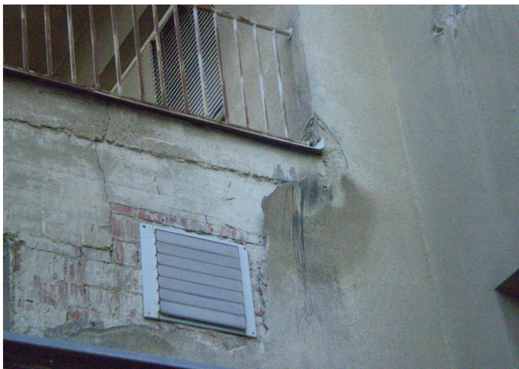
Obr. 23. Budova F, odchlípující se omítka.
