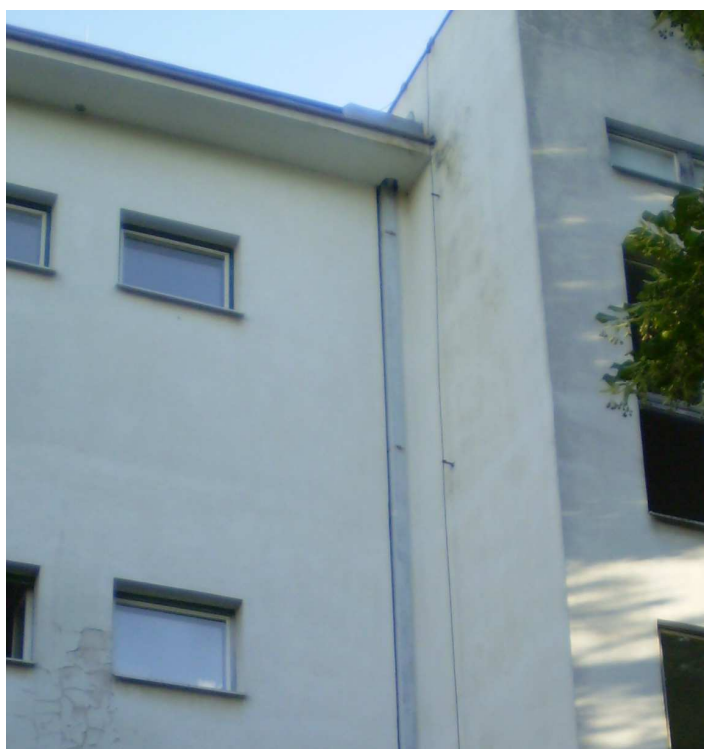
Obr. 33. Budova F ze severní strany, štěrbiny kolem okapového svodu.
