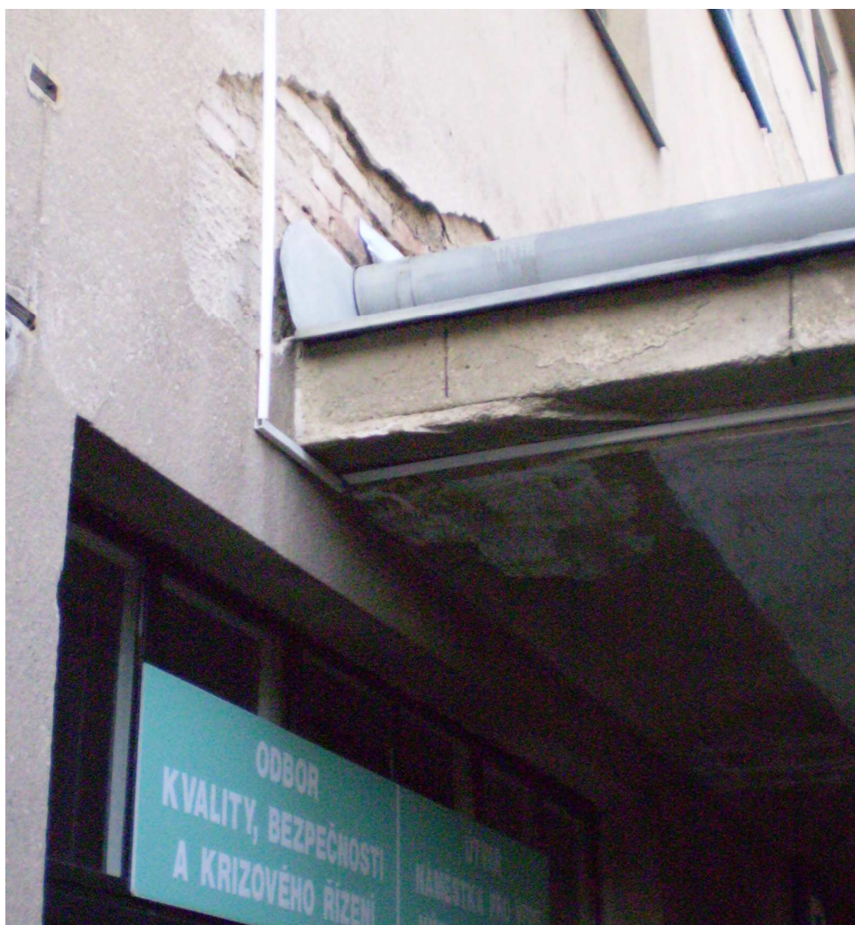
Obr. 45. Budova D1, štěrbiný pod oplechováním stříšky.
