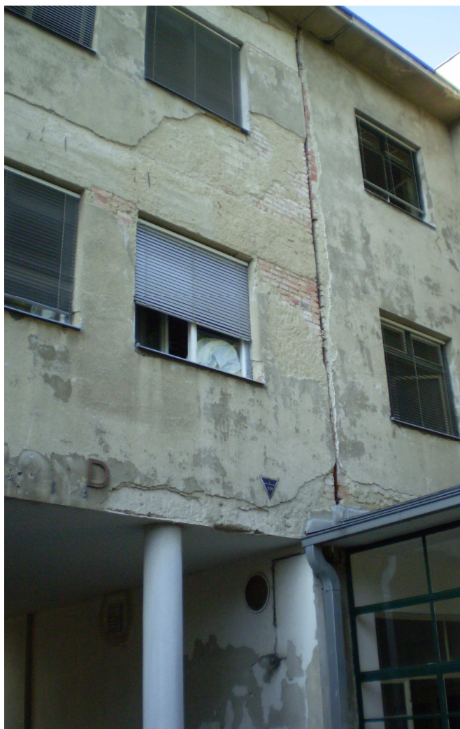
Obr. 22. Budova D1, prasklina ve zdi a škvíry pod oplechováním střechy.
