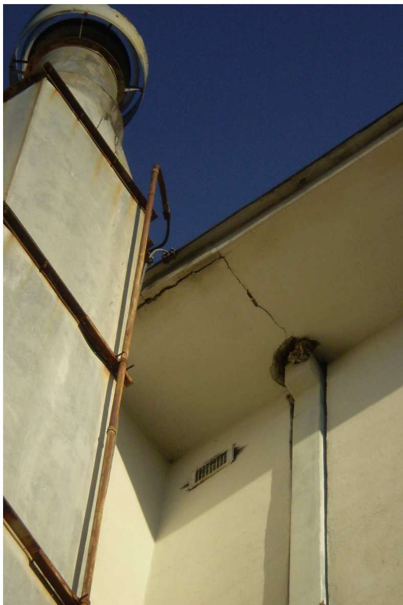
Obr. 38. Otvory a praskliny okolo okapového svodu.
