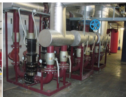
Strojovna, čerpadla horkovodní části kotelný
