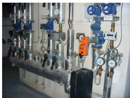
Tlakové oddělení primárního rozvodu a PS objektu D, úprava parametrů topné vody pro VZT
