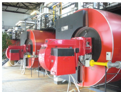
Horkovodní kotle centrální kotelný
