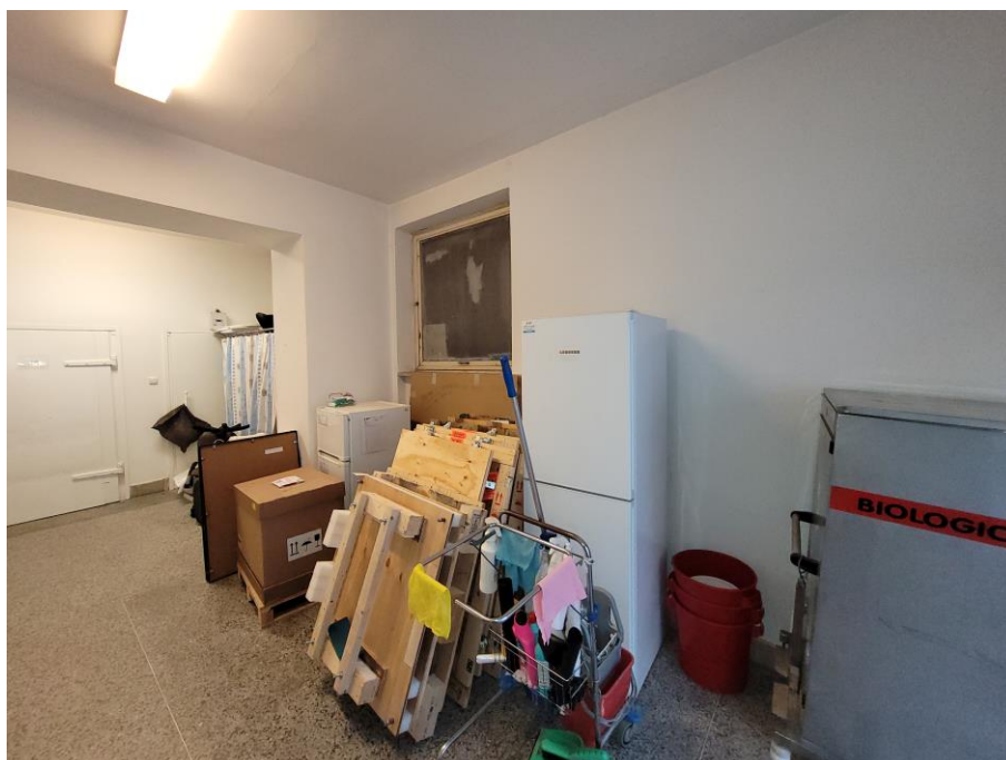
Pohled na severní stěnu místnosti „manipulační prostor“ od vstupu do místnosti z exteriéru
