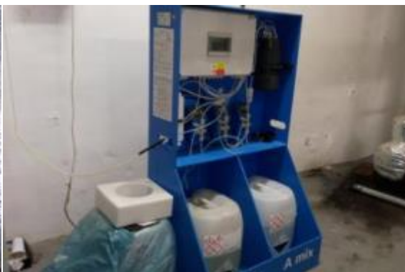
Obrázek 15 – Dávkovač oxidu chloričitého
