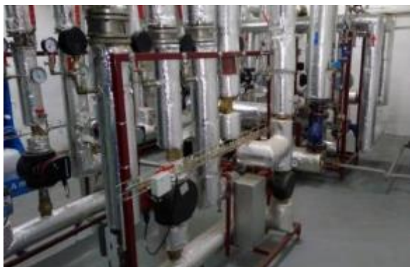
Obrázek 12 - 2x výměník pro přípravu TV
